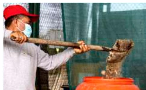
**3** Realizar la prueba de humedad de forma manual (comprimir con la mano y comprobar la consistencia de la mezcla).
